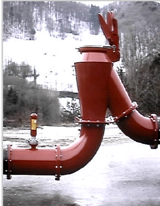
photo 11 : Cheminée de découplage à clapet [06]
