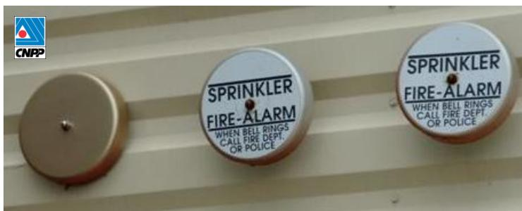
Figure 11 : Gongs hydrauliques de trois postes de contrôle
