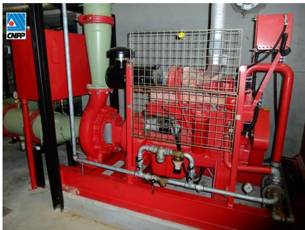
**Figure 7 : Motopompe B Diesel**
