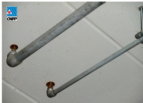
Figure 5 : Exemple de réseau pilote (à droite)
