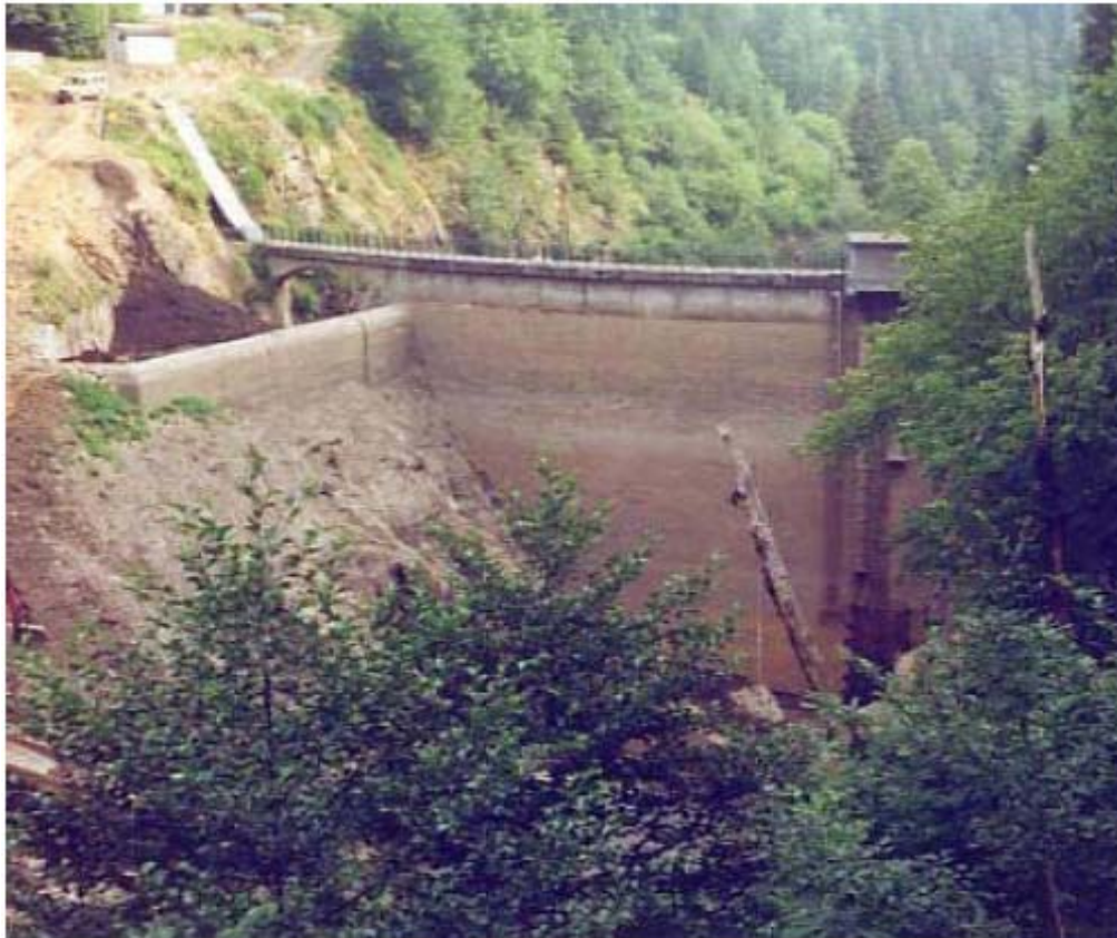
Figure 2 : Barrage de Petite-Rhue (vidangé) et son seuil latéral (source : [4])
