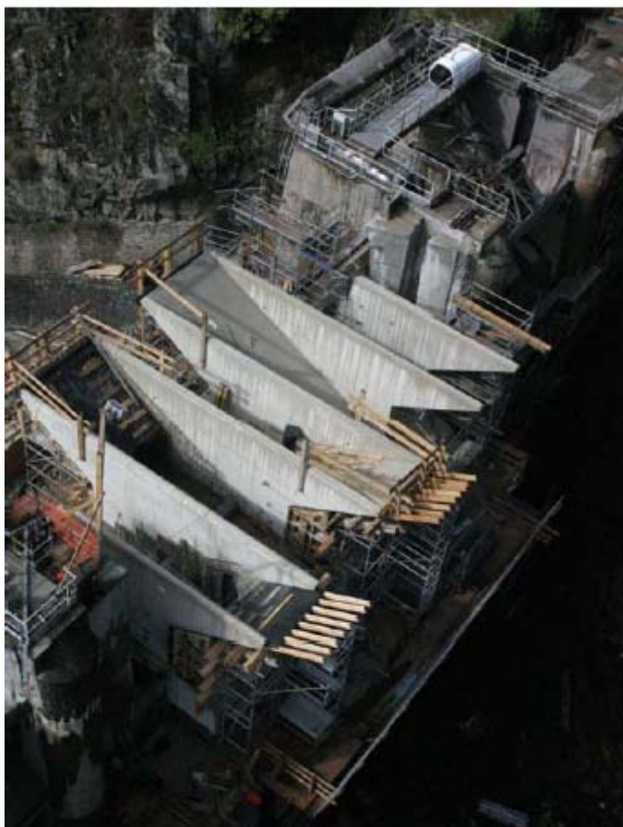
Figure 3 : Construction du seuil PKW sur le barrage de Saint-Marc (source : [5])
