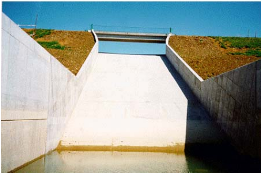
Figure 1 : Seuil déversant frontal en béton, situé sur le barrage en remblais de la Vingeanne (source : [3])
